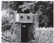
Transformatorhuisje Montfoort, Utrecht (1934)
