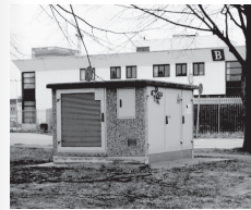
Compactstation wordt verder gestandaardiseerd door grindbeton materi- alisatie
