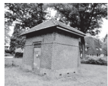
Transformatorhuisje Hattem, Gelderland (1923) L.H.J. Westerop
