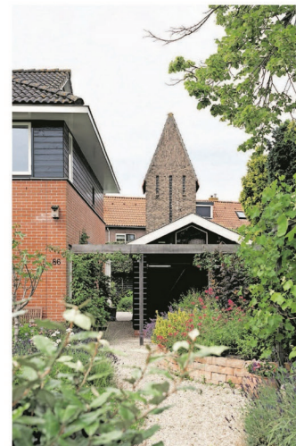
Transformatororentje, Ramplaan, Haarlem.
