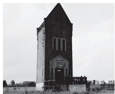
Transformatorhuisje Akersloot, Noord-Holland (1917) J.B. van Loghem
