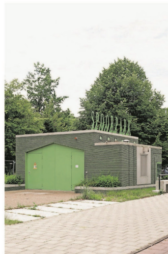
Natuurinclusief water-en-electriciteitshuisje, Postjesweg, Amsterdam.
