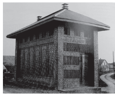
Transformatorhuisje Aerd, Gelderland (1916) G. Versteeg
