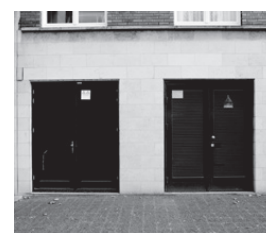
Transformatorhuisjes worden in de plint 'verstoppt'
