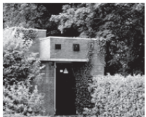
Transformatorhuisje Montfoort, Utrecht (1934)
