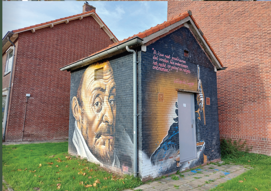
■ Middenspanningssation Nieuwe Haven Leiden (gemeentelijk monument)(boven) Middenspanningsstation Leiden Zuid (beneden). Foto's: Jasper Groos LANGE TERMIJN
